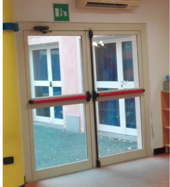
Figura 4.4 - Particolare dei serramenti
