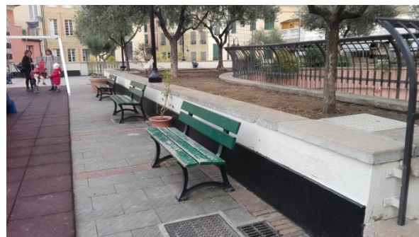
Figura 4.2 - Particolare della copertura occupata da aiuole e parco giochi
