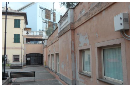
Figura 1.1 - Particolare della facciata principale esposta a Nord
